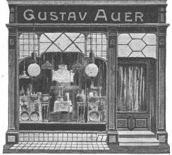
Ladenerhellung durch Solfac-Prismen als Schaufenster-Oberteil. Durch die in Messing gefaßten Prismentafeln wirkt das Schaufenster dekorativ. Der Kellerschacht ist durch Einfalllicht in Verbindung mit lotrechtem, prismatischem Fenster abgeschlossen, in welchem auch die regulierbare Entlüftung angeordnet ist.
