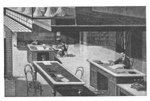
Beleuchtung eines Ladenkellers durch ein schmiedeeisernes Einfalllicht mit Solfac-Prismen No. 32 und anschließendes Stehbordfenster (Prismen No. 20) mit Lüftungsklappe
