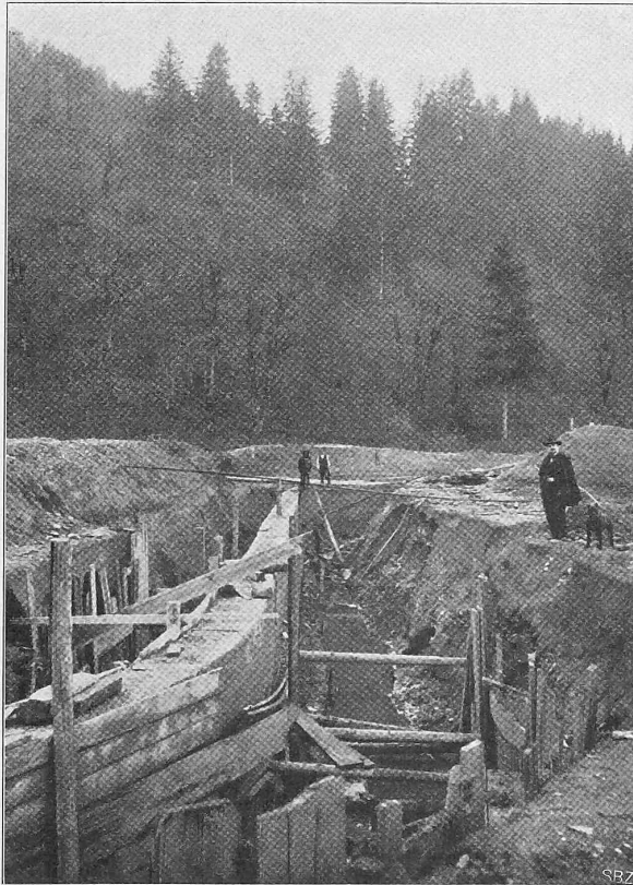
Abb. 9. Damm des Sammelweihers im Bau.
