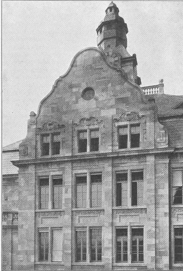
Abb. 9. Detail des Giebels der Hauptfassade.
