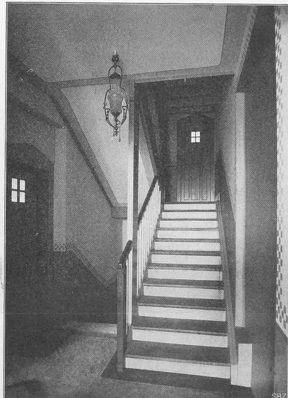
Abb. 19. Blick in das Treppenhaus des Hauses Nr. 2.
