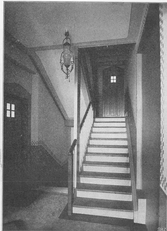
Abb. 19. Blick in das Treppenhaus des Hauses Nr. 2.
