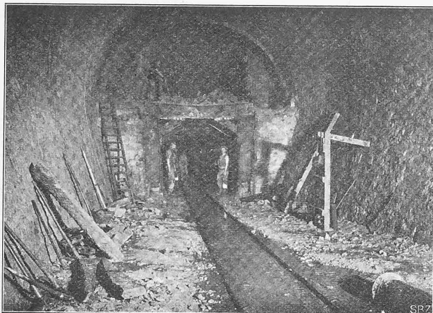
Abb. 51. Abbruch des innern Kerns nach Fertigstellung des Mauerwerks bei Km. 4,450/4,492. — 20. Januar 1904.
