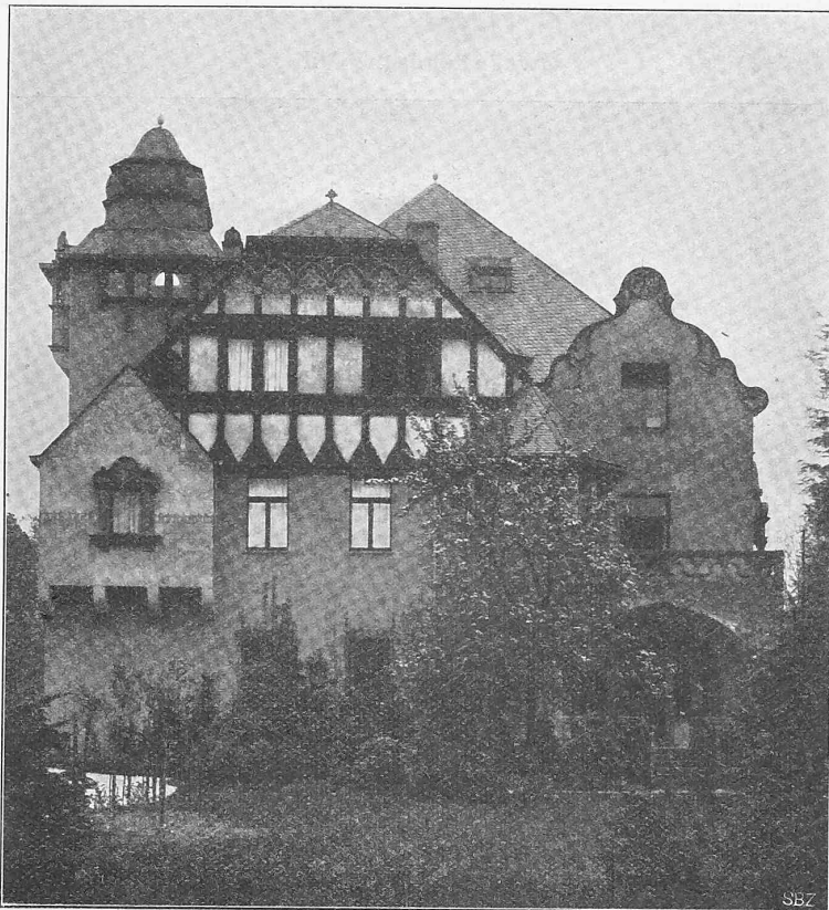
Abb. 4. Haus Osterroth in Koblenz. — Gartenfassade. Von Architekt Willy Bock in Koblenz.
