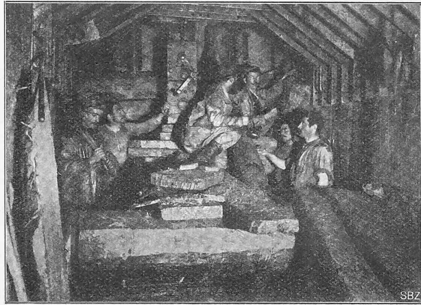
Abb. 40. Vortrieb in der Druckpartie des Stollens I. — Januar 1902.
