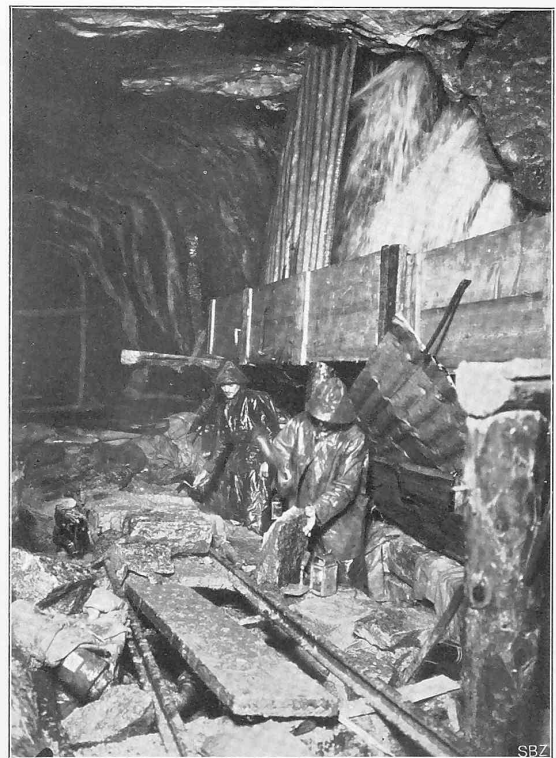
Abb. 34. Stollen II (4,442). Mauerung des Kanals unter den grossen Quellen. — 18. Dezember 1905.
