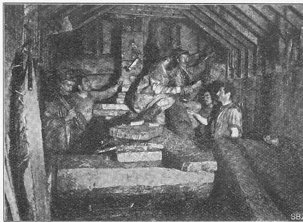
Abb. 40. Vortrieb in der Druckpartie des Stollen I. — Januar 1902.
