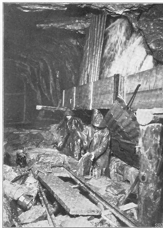
Abb. 34. Stollen II (4,442). Mauerung des Kanals unter den grossen Quellen. — 18. Dezember 1905.
