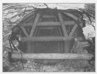
Abb. 27. Tunnel I. Km. 8,900. Vollausbruch.
