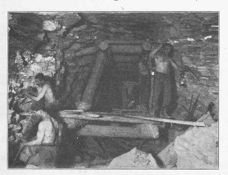
Abb 26, Tunnel I. Km. 8,850 Erweiterung der Calotte.
