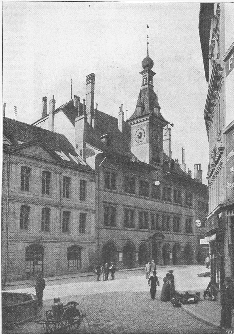
Fig. 8. Hôtel de Ville de Lausanne. — Fassade sur la Place de la Palud.
