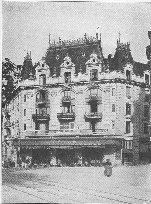
Fig. 9. Casino de Belair à Lausanne.
