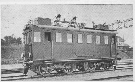
Abb. 2. Einphasen-Wechselstrom-Lokomotive (15 000 Volt) von der Maschinenfabrik Oerlikon.
