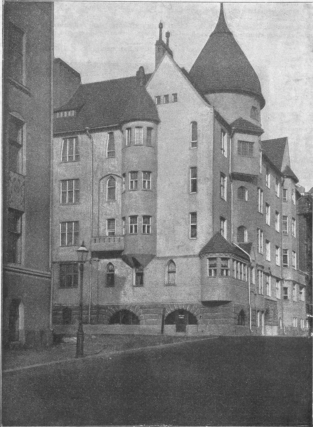
Abb. 5. Ansicht eines Wohn- und Geschäftshauses.
