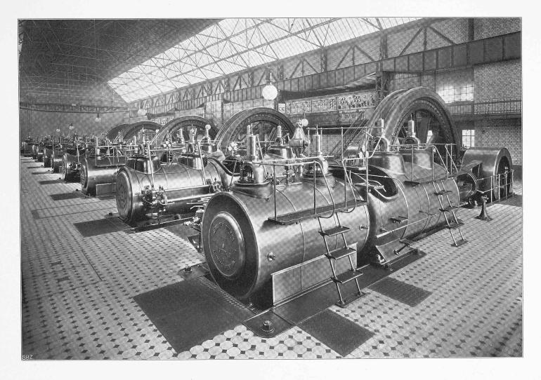
Maschinensaal der Zentrale Moabit der Berliner Elektrizitätswerke mit den 6000 P.  $S_{\ell}$  liegenden Sulzermachinen.
