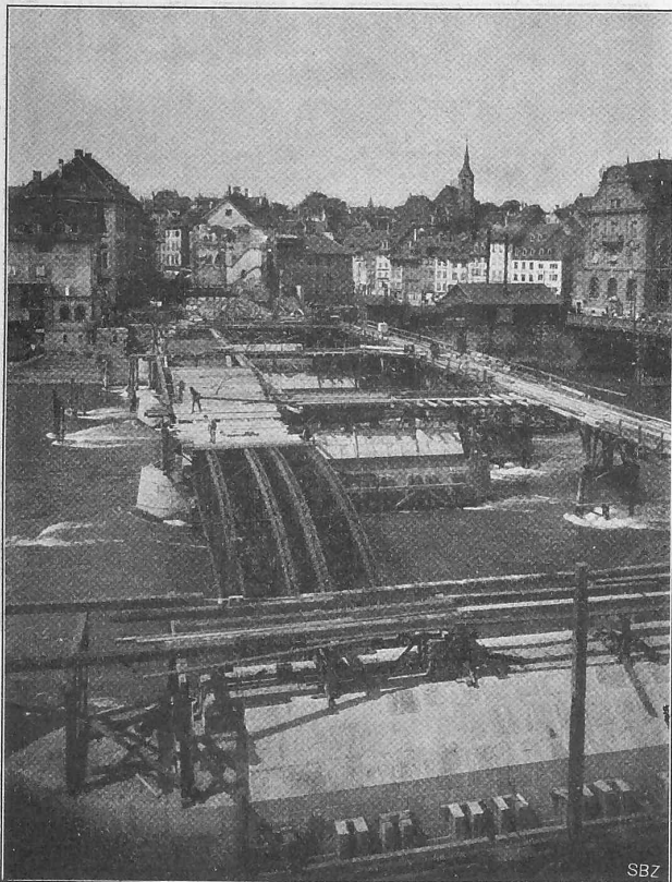
Abb. 18. Vorbereitungen zum Einwölben des ersten Gewölberinges. Juli 1904.
