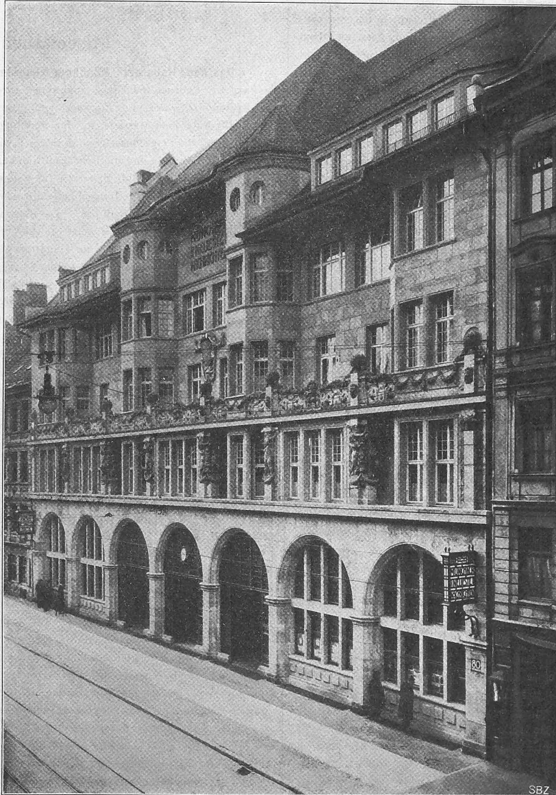
Ansicht der Hauptfassade an der Sendlingerstrasse.
