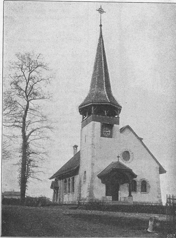
Fig. 1. Vue du côté de l'entrée principale.
