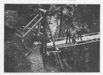
Abb. 5. Der Drahtseilsteg im Bau.
