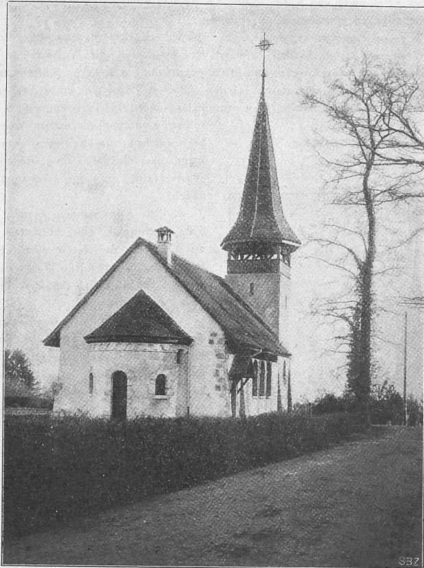
Fig. 2. Vue du chœur et de l'entrée latérale.
