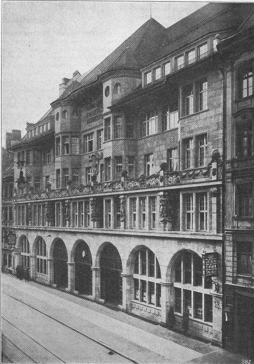
Ansicht der Hauptfassade an der Sendlingerstrasse.
