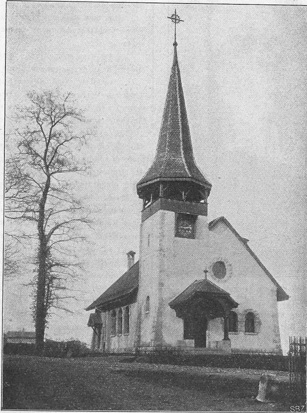
Fig. 1. Vue du côté de l'entrée principale.
