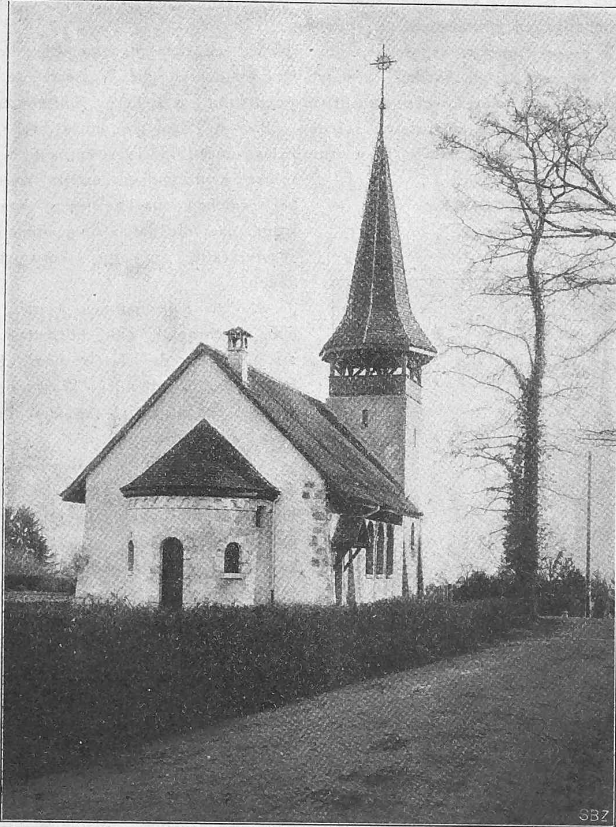
Fig. 2. Vue du choeur et de l'entrée latérale.
