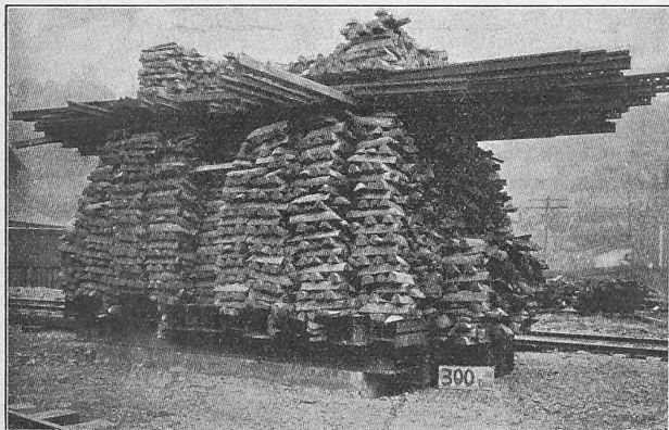
Abb. 50. Probelastung von «Simplex»-Pfählen.
