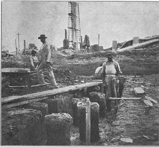
Abb. 49. Freigelegte Köpfe von «Simplex»-Pfählen.
