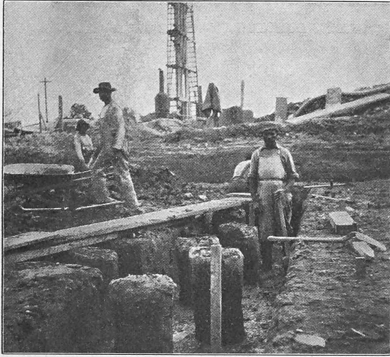
Abb. 49. Freigelegte Köpfe von «Simplex»-Pfählen.
