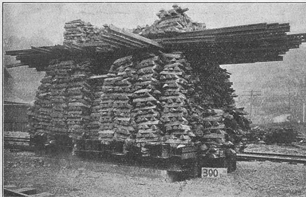
Abb. 50. Probelastung von «Simplex»-Pfählen.
