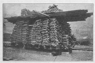
Abb. 50. Probebelastung von «Simplex»-Pfählen.
