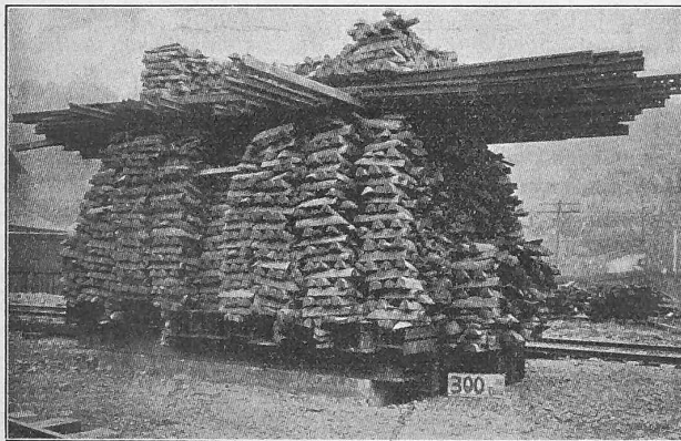
Abb. 50. Probelastung von «Simplex»-Pfählen.
