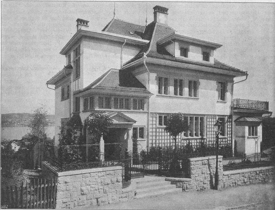
Abb. 5. Villa Kehl in der Bellariastrasse in Zürich II. — Ansicht von Nordwest. Erbaut von den Architekten Pfleghard & Haefeli in Zürich.
