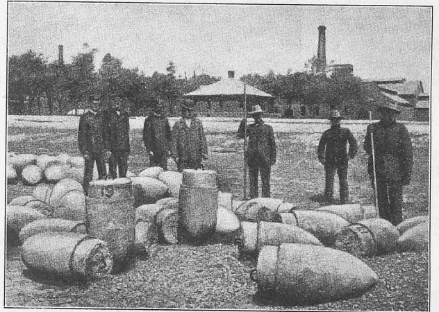
Abb. 42 Pfahlspitzen aus mit Streckmetall armiertem Beton.
