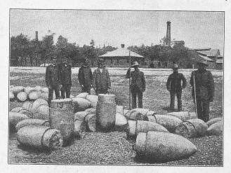
Abb. 42 Pfahlspitzen aus mit Streckmetall armiertem Beton.
