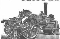
llefert kaufsund mietweise DAMPFSTRASSENWALZEN, Patent Aveling & Porter, mit oder ohne mechanischem Strassenaufbrecher; in Gebrauch bei einer grössern Anzahl schweiz, Behörden. Strassenlokomotiven zur Beförderung leichter und schwerer Lasten.
