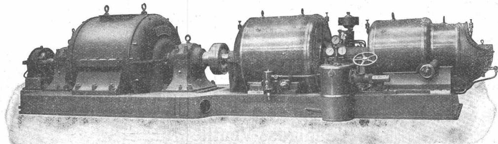
direkt gekuppelt mit Generatoren für Gleich-, Wechsel- oder Drehstrom
