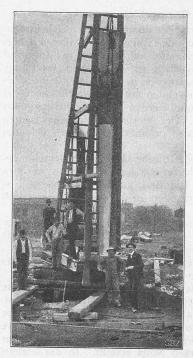
Abb. 37. Rammkern in die Stahlhülse eingeführt.
