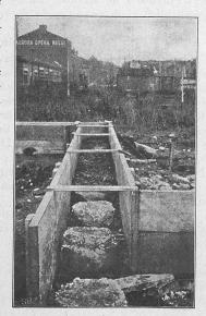
Abb. 38. Betonpfahlköpfe in den Mauerfundamenten.
