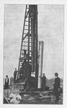
Abb. 36. Stahlhülse und aufgezogener Rammkern.
