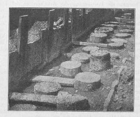
Abb. 39. Pfahlköpfe zur Aufnahme des Betonmauerkörpers bereitgestellt.
