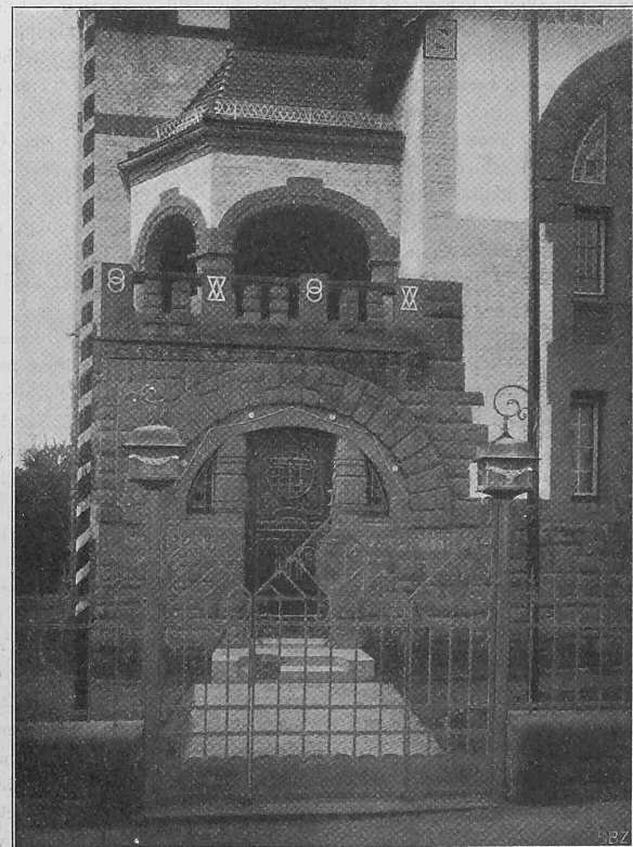
Abb. 3. Ansicht des Haupteingangs
