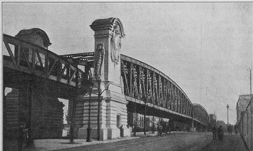
Abb. 8. Ueberbrückung der Nordbahn.
