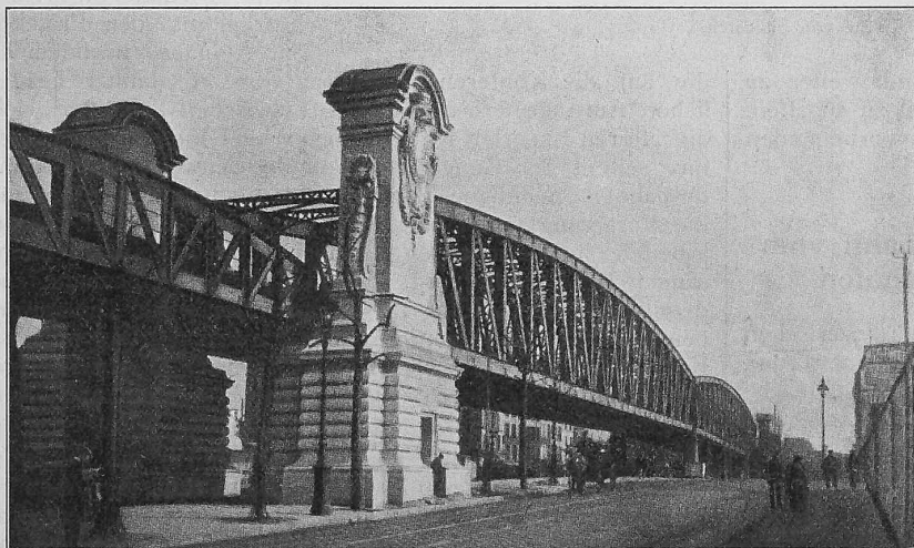
Abb. 8. Ueberbrückung der Nordbahn.
