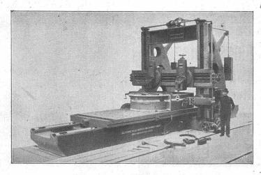
Hobelmaschine von 2500 mm Durchgang.
