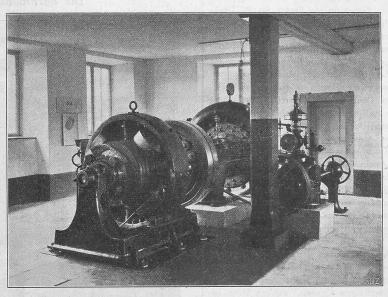
Abb. 18. Gruppe von 200 P. S. Turbine und Gleichstromgenerator.
