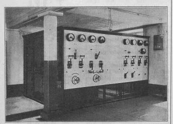
Abb. 21. Schalttafel zur Apparatenanlage der Zentrale der Sernftalbahn.
