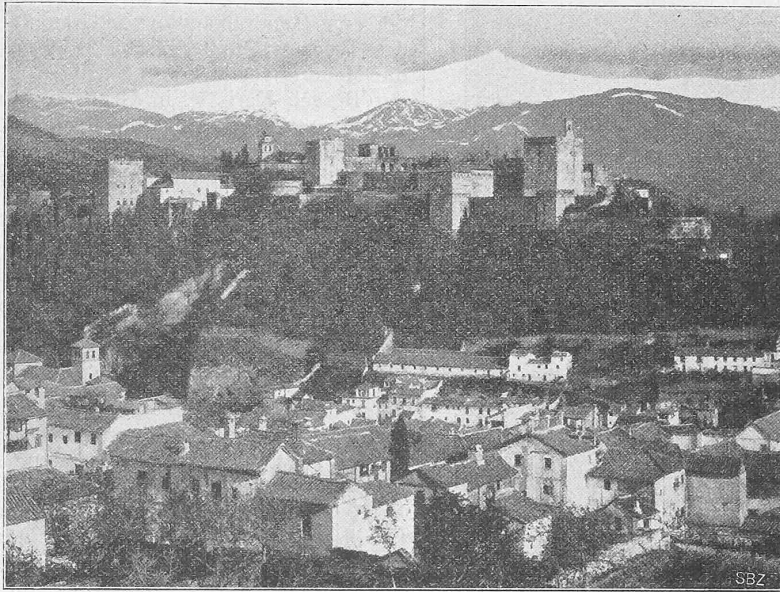
Abb. 5. Ansicht der Alhambra mit der Sierra Nevada.
