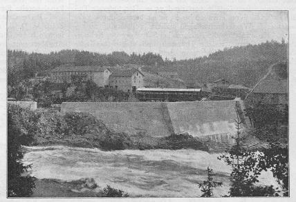
Abb. 2. Linksseitiges Wehr, bezw. Staumauer.
