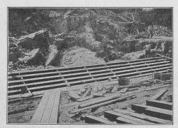
Abb. 3. Trägerrost über dem alten Bergwerksgang.
