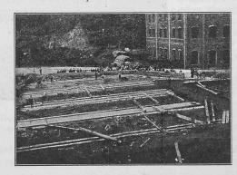
Abb. 10. Massive Auflagerschwellen des Lehrgerüstes.
