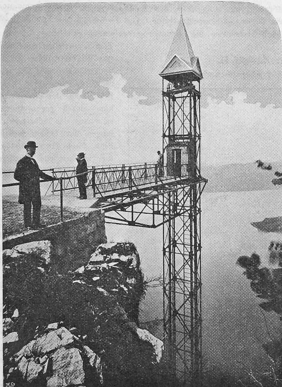
Abb. 3. Obere Plattform und Zugangssteg.
