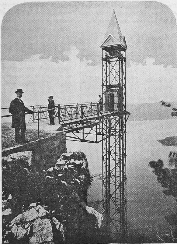
Abb. 3. Obere Plattform und Zugangssteg.
