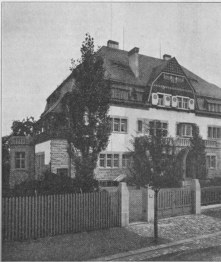
Abb. 9. Ansicht eines Teiles der West- und Nordfassaden.
