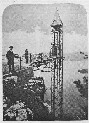
Abb. 3. Obere Plattform und Zugangssteg.
