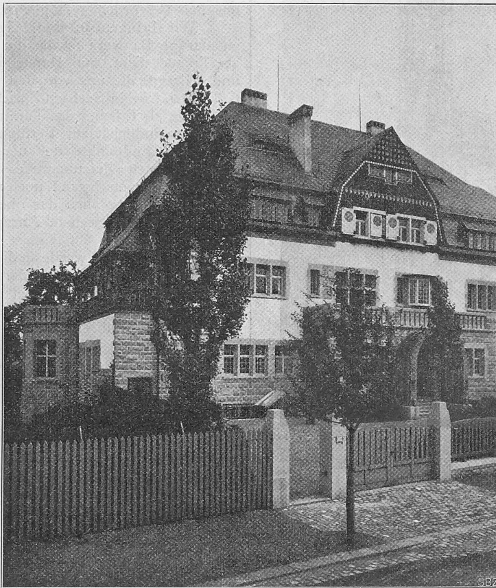
Abb. 9. Ansicht eines Teiles der West- und Nordfassaden.
