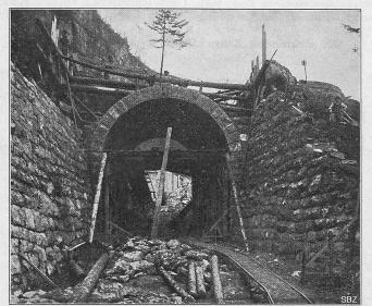
Abb. 11. Gewölbte Strassen-Ueberführung im Bau.
