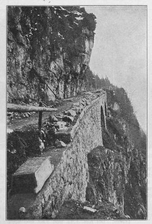
Abb. 8. Lehnenviadukt im Bau.
