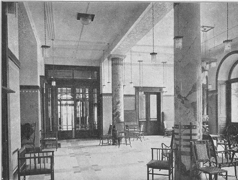
Abb. 2. Blick in die Halle.
