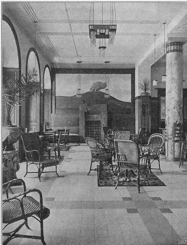
Abb. 1. Blick in die Halle gegen die Kaminwand.
