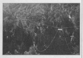
Abb. 7. Röhrentransport über bie Fätschbachschlucht.
