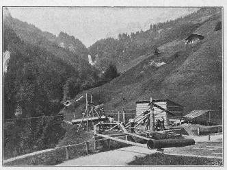
Abb. 6. Röhrentransport über die Fätschbachschlucht.
