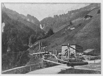
Abb. 6. Röhrentransport über die Fätschbachschlucht.
