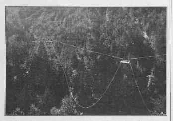
Abb. 7. Röhrentransport über bie Fätschbachschlucht.
