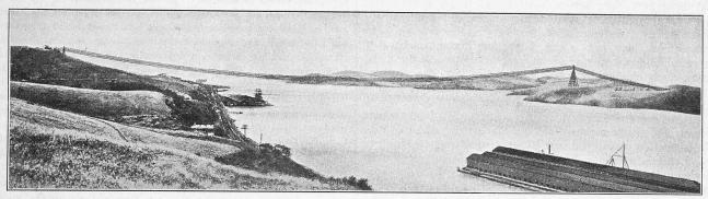
Abb. 18. Seilspannung über die Meerenge von Carquinez in Kalifornien.
