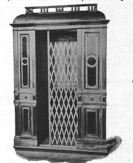
Druckknopf-Seilsteuerung, sicherst wirkende Fangvorrichtung, geräuschloser Gang, automatische Schachtsicherungen.
