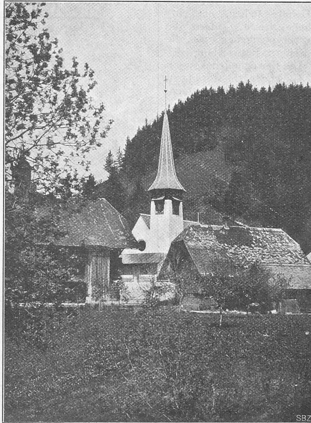
Abb. 7. Ansicht von Süd-Osten.
