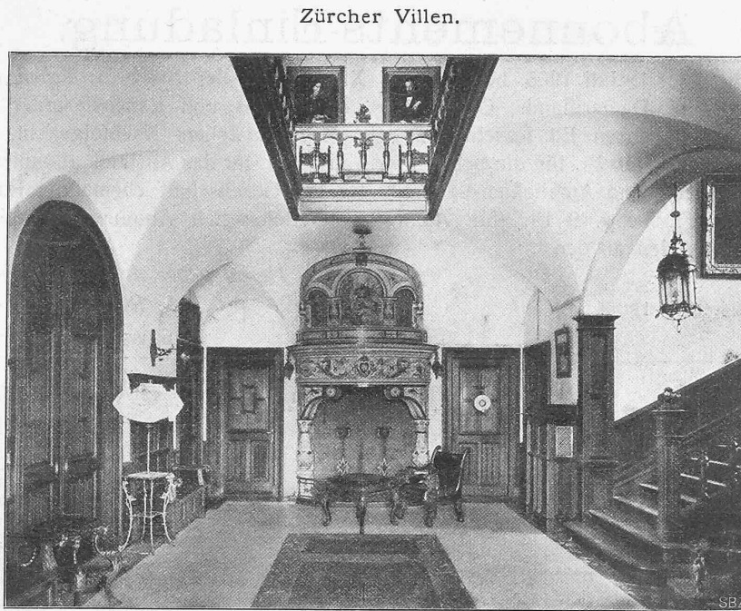
Abb. 16. Blick in die Halle der Villa Baumann in Zürich II.
