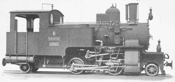
Abb. 7. Neue Lokomotive der Strassenbahn St. Gallen-Gais-Appenzell. — Typ vom Jahre 1904. Erbaut von der *Schweizerischen Lokomotivfabrik* in Winterthur.
