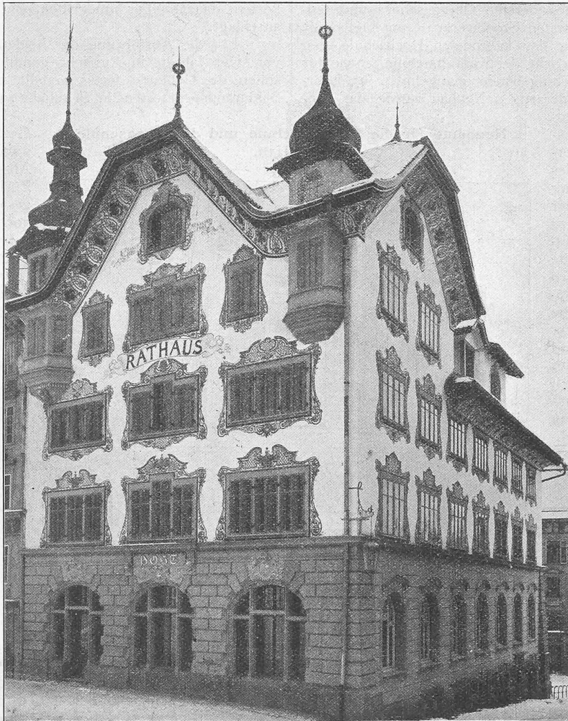
Das Rathaus zu Einsiedeln nach dem Umbau.
