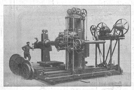
Horizontal-Bohr- und Fräsmaschine mit elektrischem Antrieb.
