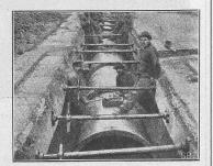
Abb. 18. Anwendung ausziehbarer Spriessen.
