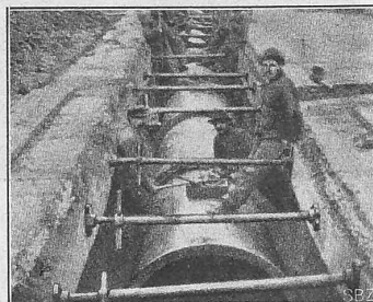
Abb. 18. Anwendung ausziehbarer Spriessen.
