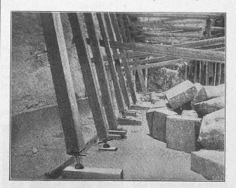
Abb. 17. Anwendung ausziehbarer Spriessen.
