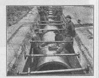
Abb. 18. Anwendung ausziehbarer Spriessen.
