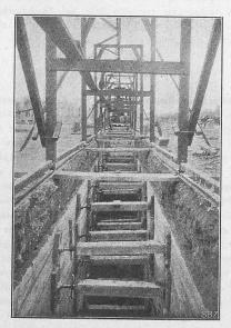
Abb. 16. Anwendung ausziehbarer Spriessen.
