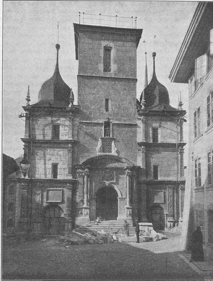
Abb. 1. Die alte Ostfassade des Rathauses zu Solothurn.
