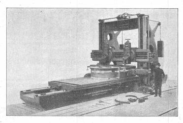
Hobelmaschine von 2500 mm Durchgang.
