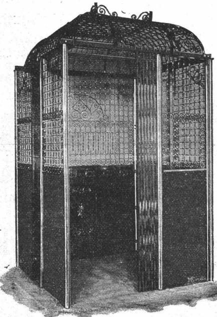
Druckknopf-Seilsteuerung, sicherst wirkende Fangvorrichtung, geräuschloser Gang, automatische Schachtsicherungen.
