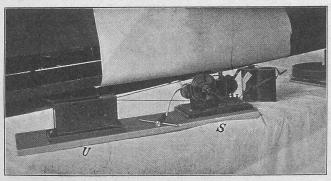
Abb. 12. Das Registrierwerk. (U Uhrwerk, S Registrierwerk.)
