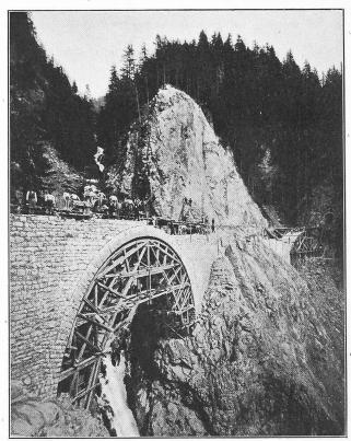
Abb. 21. Die Stulsertobel-Brücken im Bau.
